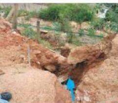
Erosão, proveniente do lançamento de aterro e da falta de drenagem na encosta
