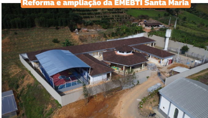
Reforma e ampliação da EMEBTI Santa Maria
