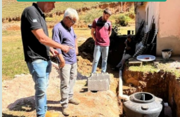
Instalação de Biodigestor
