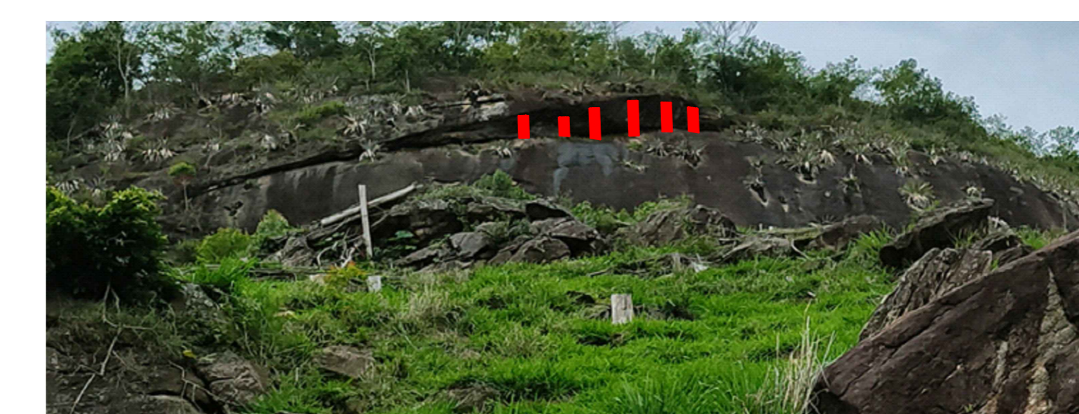
ROCHA COM A ESTABILIZAÇÃO IMPLEMENTADA
