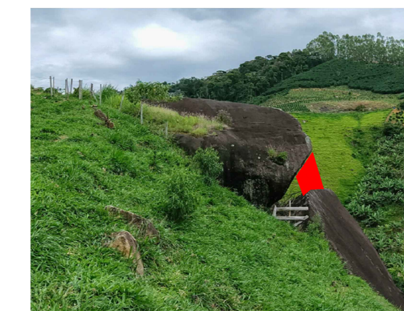
ROCHA COM A ESTABILIZAÇÃO IMPLEMENTADA
