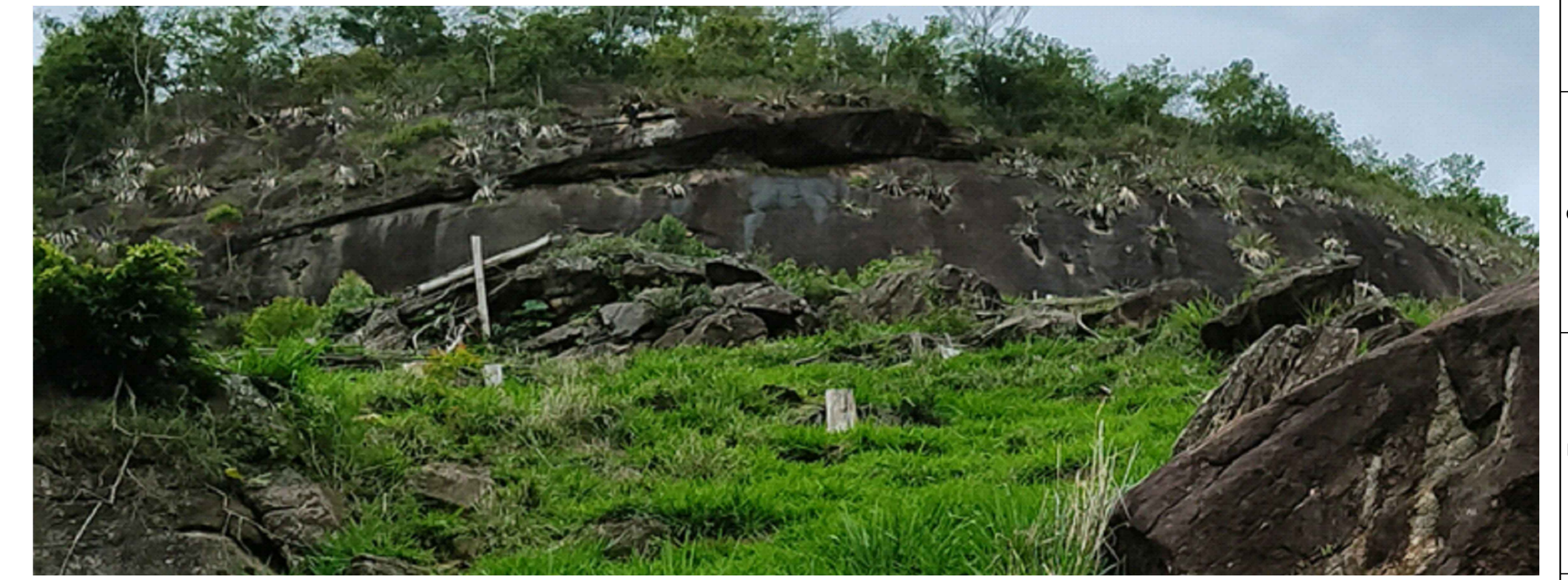
ROCHA A SER ESTABILIZADA 06 (VISTA INFERIOR) S/Esc.
