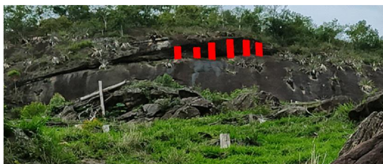
Figura 14 - Rocha 06 com sistema de estabilização implantado.
