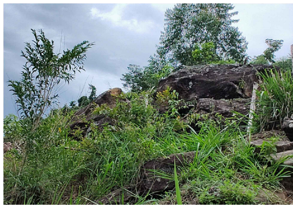
ROCHA A SER ESTABILIZADA 01 (VISTA INFERIOR) S/Esc.
