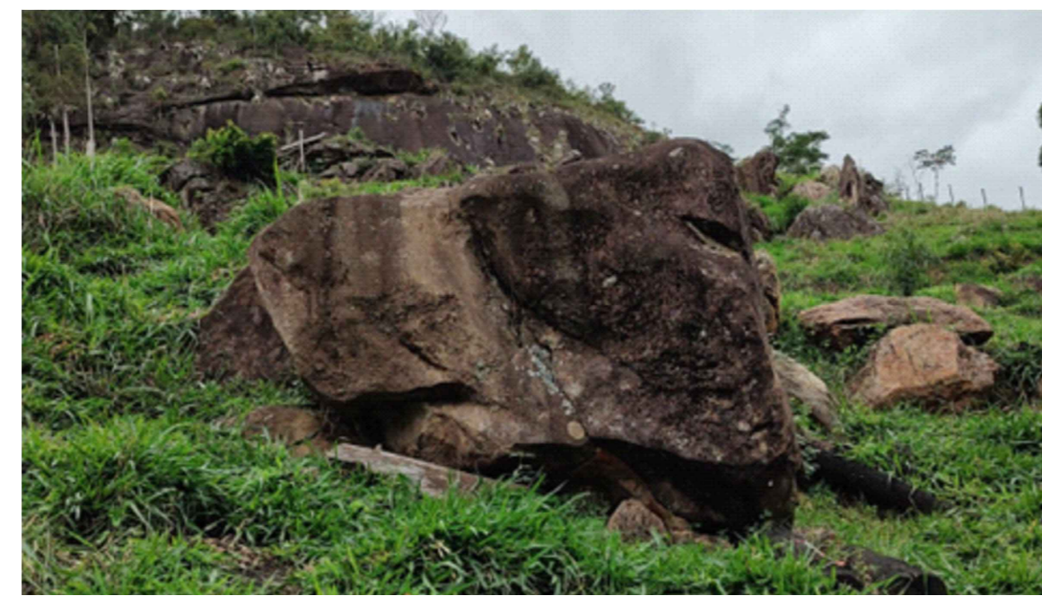
ROCHA A SER ESTABILIZADA 02 (VISTA INFERIOR) S/Esc.
