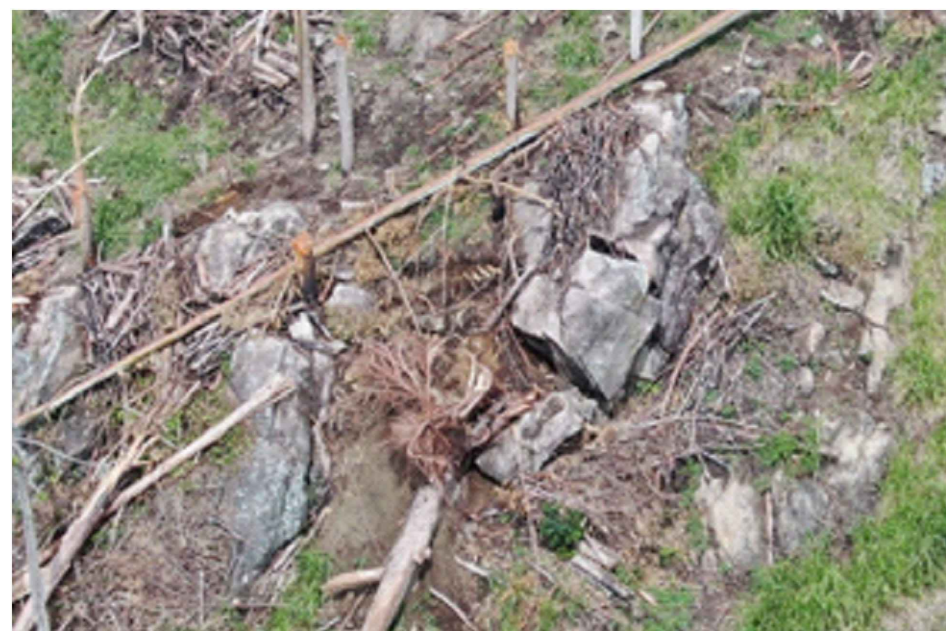
ROCHA A SER ESTABILIZADA 01 (VISTA AÉREA) S/Esc.
