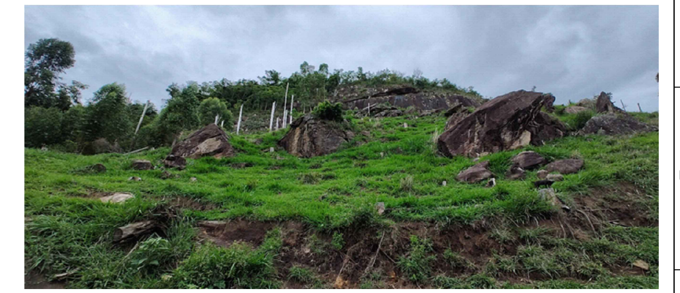
ROCHA A SER ESTABILIZADA 05 (VISTA INFERIOR) S/Esc.
