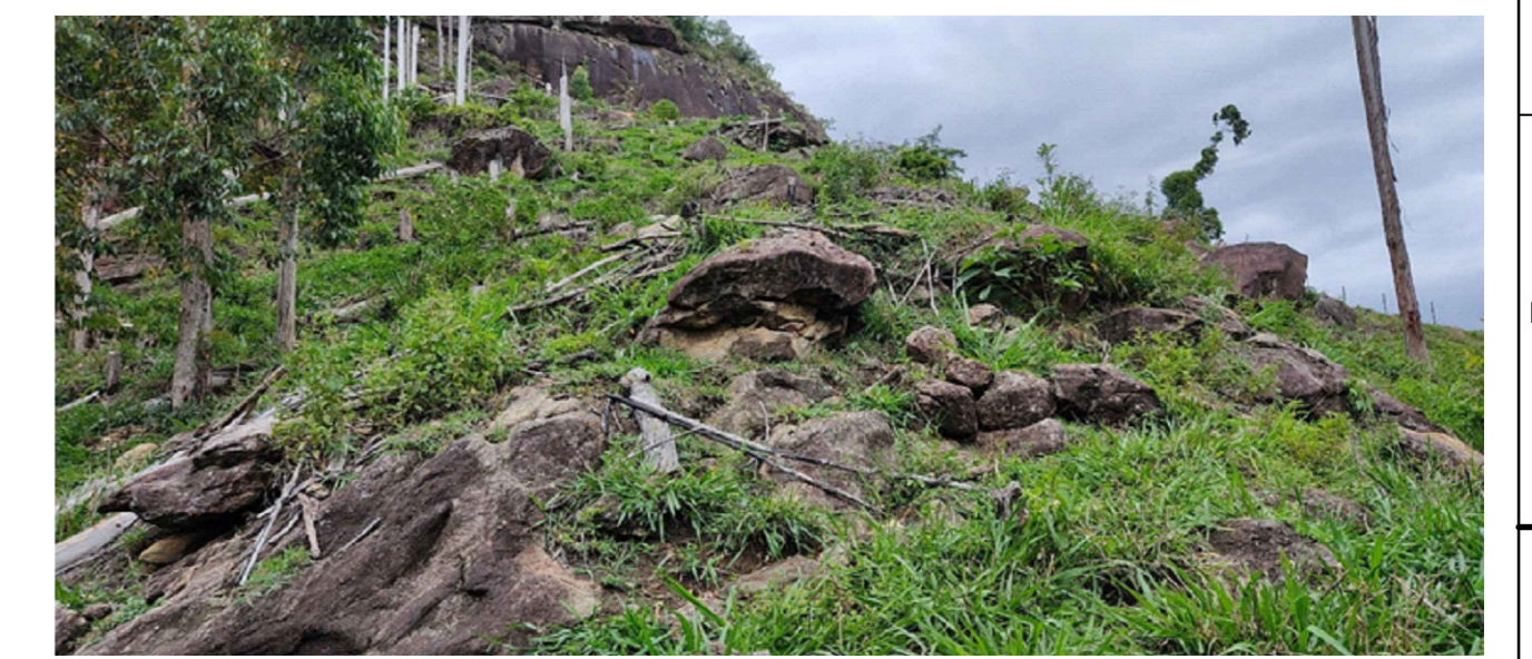
ROCHA A SER ESTABILIZADA 04 (VISTA INFERIOR) S/Esc.
