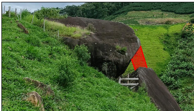
Figura 13 - Rocha 03 com sistema de estabilização implantado.
