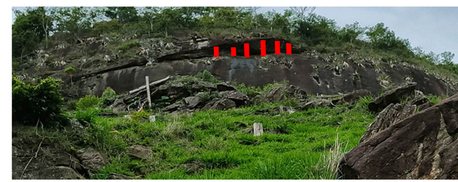
ROCHA COM A ESTABILIZAÇÃO IMPLEMENTADA
